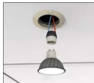
3. Liitä polttimo alasvalon kantaan ja asenna se haluttuun asentoon.
