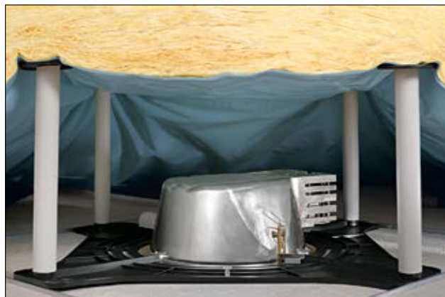
SpotClip-Plate, SpotClip-Cap ja SpotClip-Tube asennettuna.
