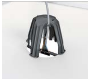
2. Paina tukijalkojen piikit kipsilevyyn pyörimisen estämiseksi ja irrota asennustyökalu.
