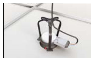
4. Kytke johtimet ja kiinnitä ne johdinpidikkeeseen.
