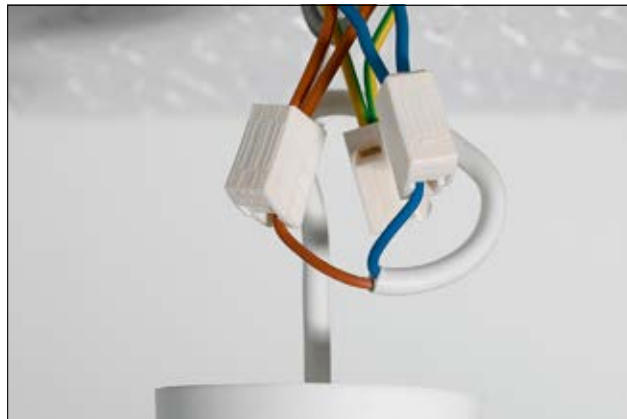
HelaCon Lux-sarjan rasialiittimet soveltuvat valaisinasennuksiin.
