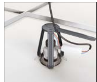
4. Kytke virtalähteen johtimet ja kiinnitä ne johdinpidikkeeseen.
