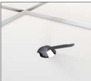
1. Pujota SpotClip-III asennusreikään.
